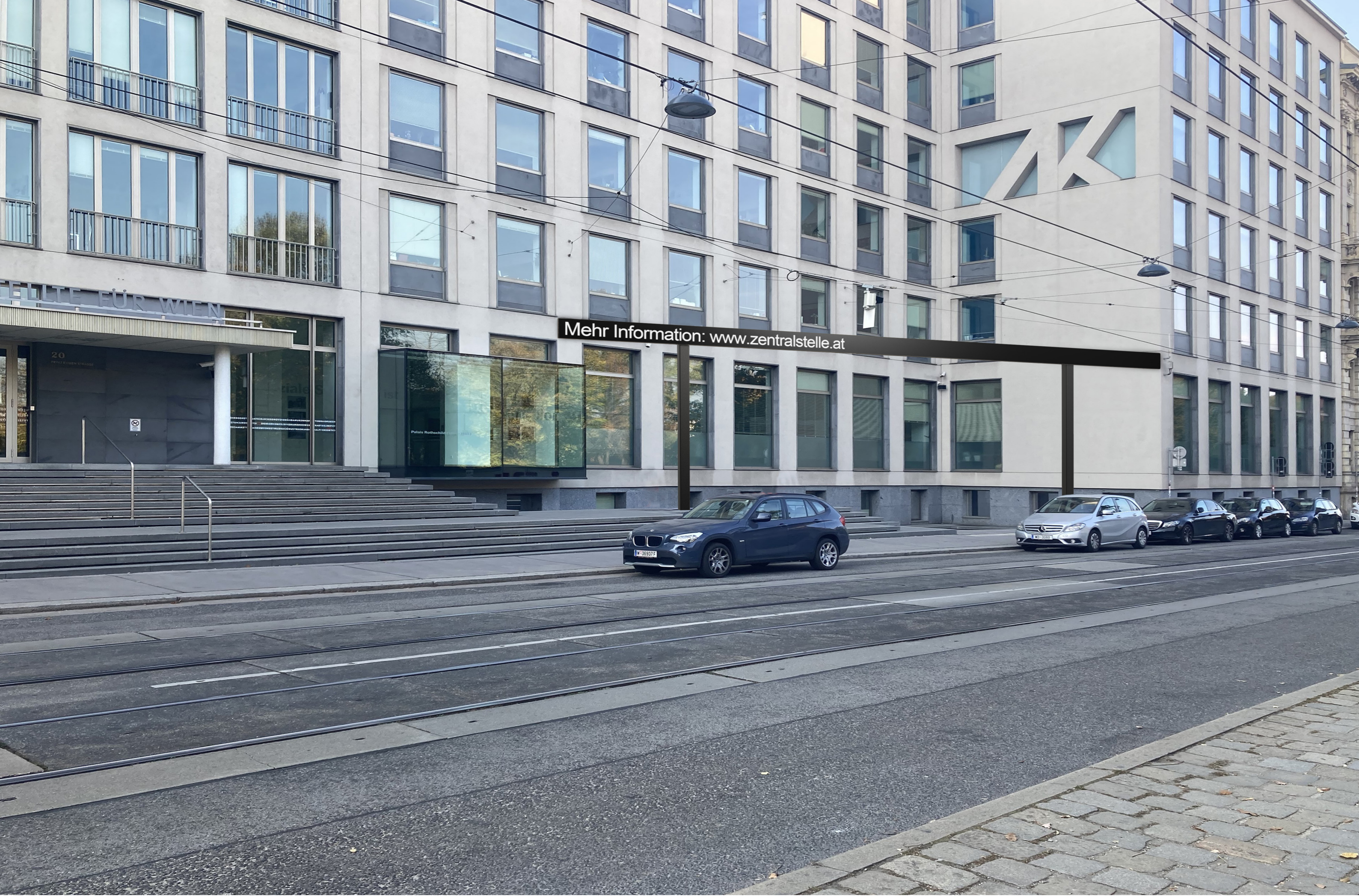
Ansicht Nordwest LED-Schriftleiste mit Stützfeilern
